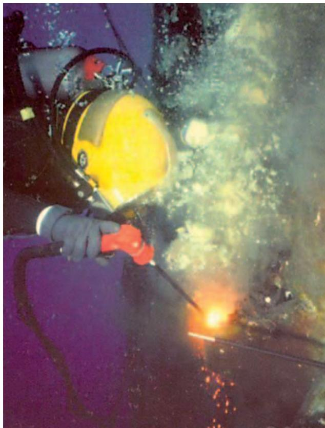
Fig. 147 - Sommozzatore d'alto fondale con elmo integrale intento al taglio di una clampa su una gamba di piattaforma con una moderna pinza ossi-elettrica con elettrodi di metallo (g.c. Marine Consulting Diving Contractors).
